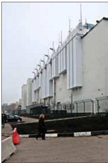
Вертикальное размещение модулей EcoBreeze на крыше ЦОДа DataPro
