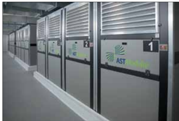
Модульная система охлаждения NFC в ЦОДе “ВымпелКома”
