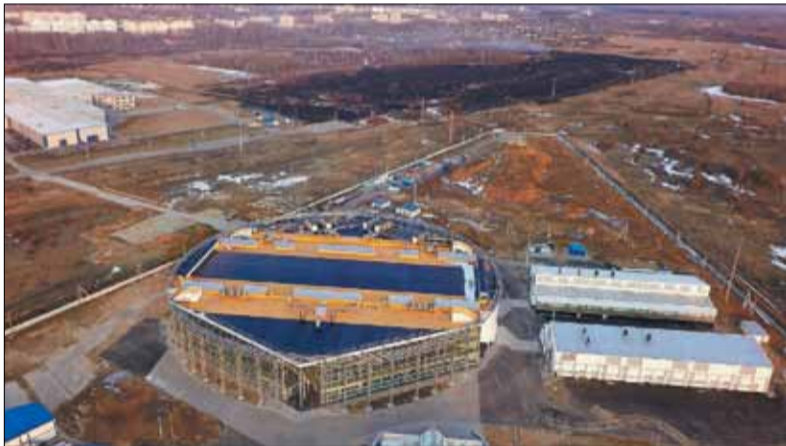
Новый ЦОД “ВымпелКома” в Ярославле разместился на площадке в 7 га
